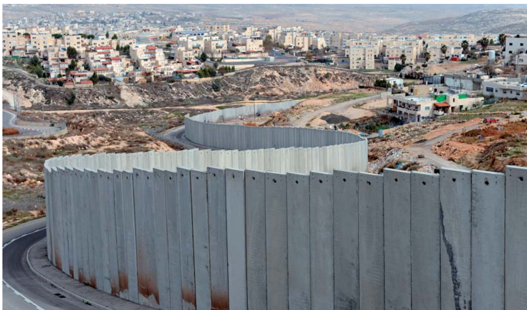
Il muro di separazione
